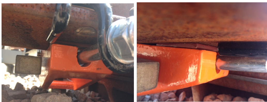
Figur 3. Montering av kil 1:30
